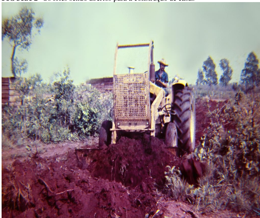
FIGURA 2- Os lotes sendo abertos para a construção de casas
