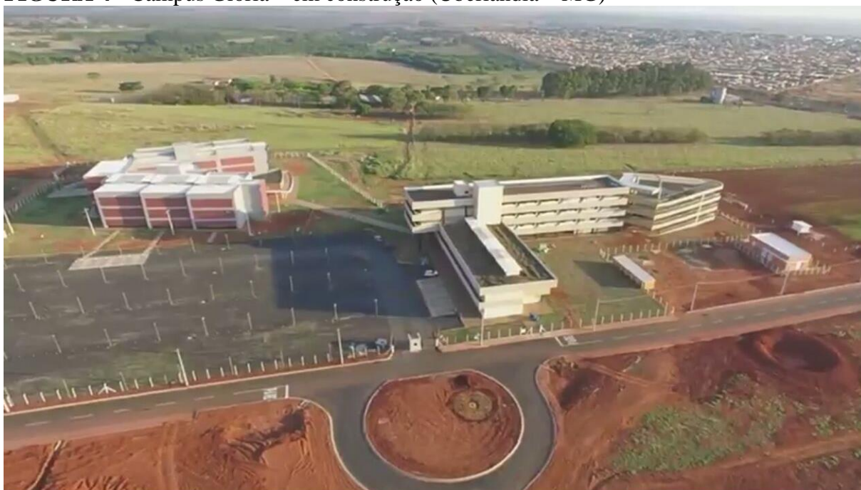
FIGURA 4 - Campus Glória – em construção (Uberlândia – MG)
