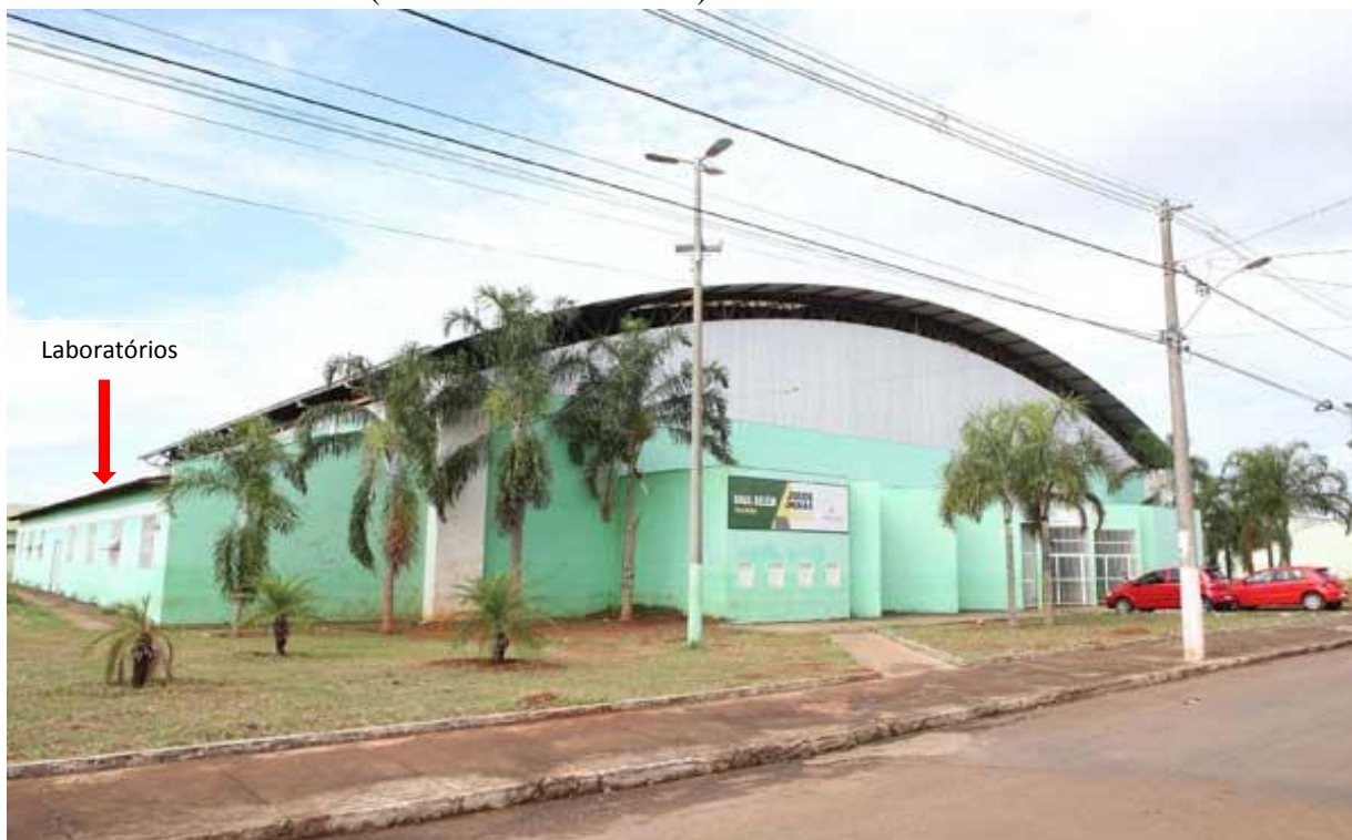
FIGURA 9 - Ginásio dividido entre quadra de esportes e laboratórios da UFU/Monte Carmelo (Monte Carmelo – MG)
