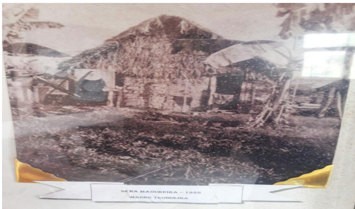
Figura 3 - Primeiras estruturas para ação de escolarização das SMR
