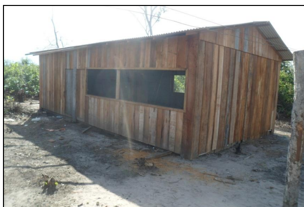
FIGURA 8 - Sala anexa na aldeia Halataikwa
